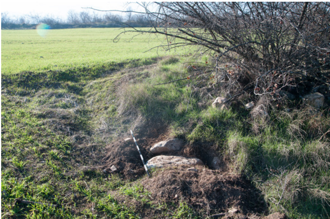
Photograph 5: The western corridor wall of the eastern gate; a view from the east / западниот ѕид од источниот влезен коридор, поглед од исток
